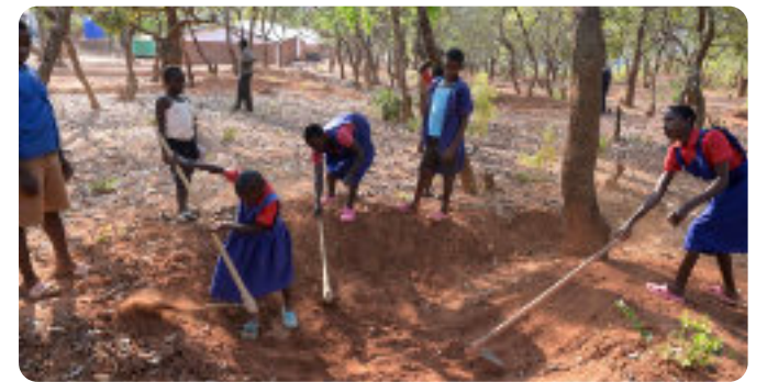
Die Schüler*innen legen Gräben zum Schutz vor Erosion an. Sie sollen das Wasser ableiten – sobald die Regenzeit beginnt.
